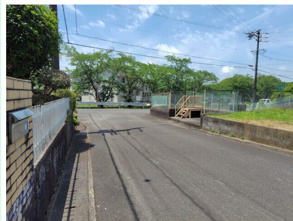
前面道路 (南東側) より撮影
