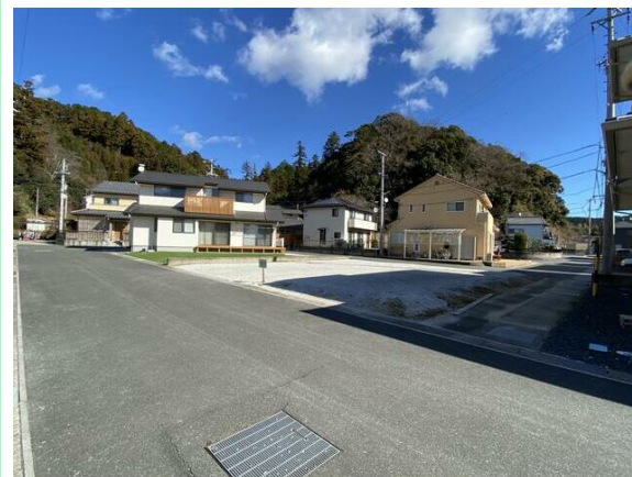
12号地: 南西より
