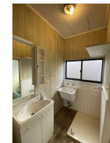
1階脱衣・洗面室
